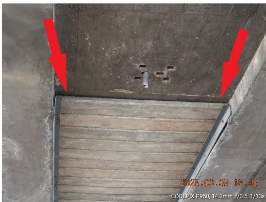
Fot. 7 - Kraków, Most Grunwaldzki, płyty pod mostem, zaznaczono szczeliny mogące stanowić miejsce przebywania nietoperzy_20250309_
