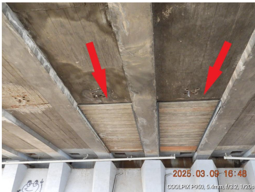
Fot. 6 - Kraków, Most Grunwaldzki, płyty pod mostem, zaznaczono szczeliny mogące stanowić miejsce przebywania nietoperzy_20250309_
