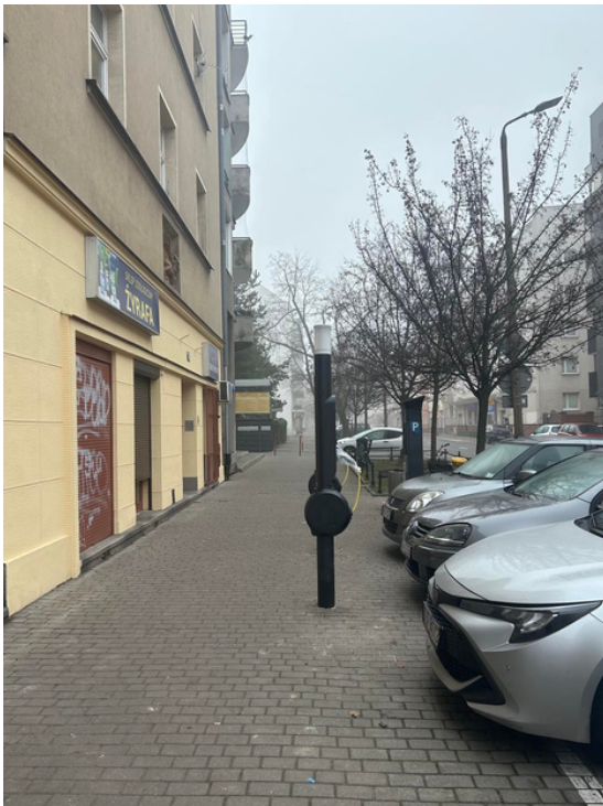
Ładowarki przy ul. Kazimierza Wielkiego
