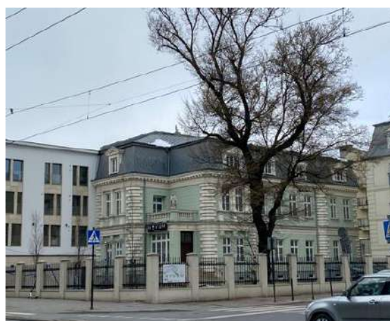
Fot. 64. Kamienica przy ul. Lubicz 42 – zabudowania znajdujące się nad planowanym tunelem (źródło: Ekovert)
