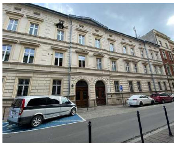
Fot. 62. Kamienice przy ul. Zaczysze 5, 7 – zabudowania znajdujące się nad planowanym tunelem (źródło: Ekovert)
