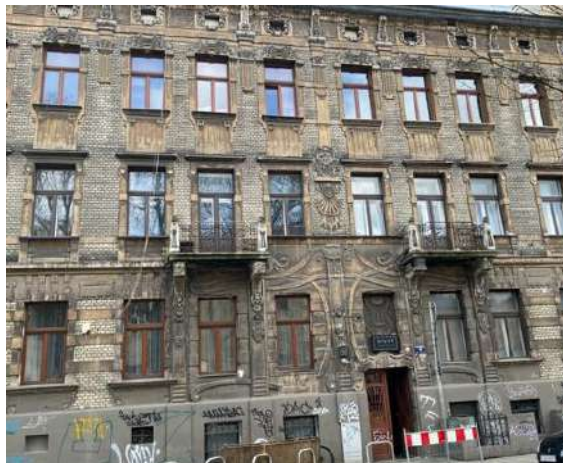
Fot. 54. Kamienica przy ul. Łobzowskiej 4 – zabudowania znajdujące się nad planowanym tunelem (źródło: Ekovert)
