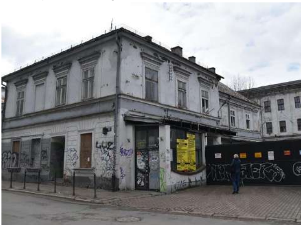
Fot. 51. Budynki dawnej fabryki tytoniu przy ul. Dolne Młyny – zabudowania znajdujące się bezpośrednio nad planowanym tunelem (źródło: Ekovert)
