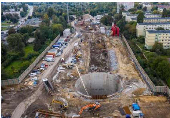
Fot. 69 Przygotowania do drążenia tunelu średnicowego w Łodzi (źródło: https://lodz.wyborcza.pl/lodz/7,35136,26934131,tunel-dla-kolei-duzych-predkosci-w-lodzi-krok-blizej-budowy.html )
