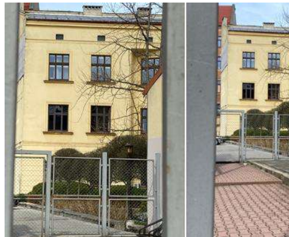
Fot. 52. Kamienica przy ul. Czystej 21– zabudowania znajdujące się bezpośrednio nad planowanym tunelem (źródło: Ekovert)
