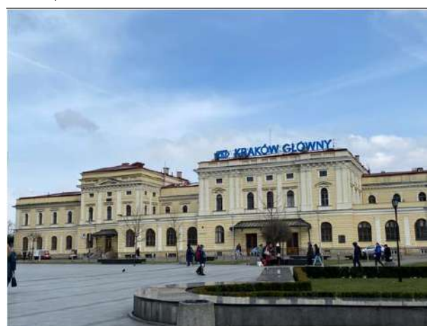
Fot. 63. Dworzec PKP – zabudowania znajdujące się nad planowanym tunelem (źródło: Ekovert)
