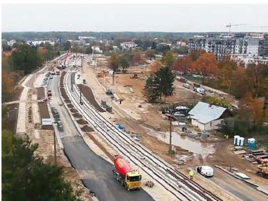
Fot. 65 Przykład prac związanych z budową torowiska w Warszawie (źródło: https://tustolica.pl/w-20-minut-do-metra-finish-na-budowie-torowiska-tramwajowego_83942 )
