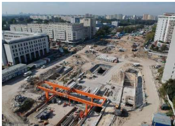
Fot. 70 Budowa metra na ul. Kondratowicza (źródło: https://warszawa.wyborcza.pl/warszawa/7,54420,26686370,nowe-nazwy-stacji-metra-ale-radni-pogubili-sie-w-zmianach-przystankowych.html )
