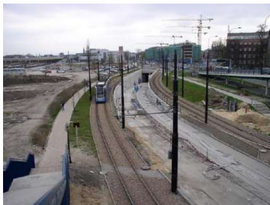
Fot. 66 Budowa rampy wjazdowej do tunelu Krakowskiego Szybkiego Tramwaju w ok. Ul. Pawiej – 2008 r. (źródło: https://pl.wikipedia.org/wiki/Tunel_Krakowskiego_Szybkiego_Tramwaju )
