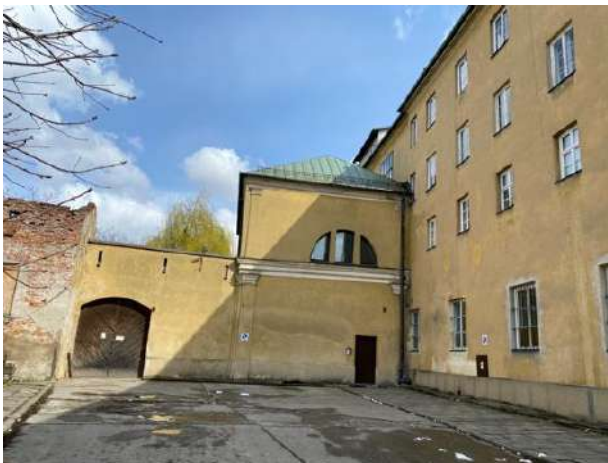
Fot. 53. Klasztor przy ul. Karmelickiej 19 – zabudowania znajdujące się nad planowanym tunelem (źródło: Ekovert)
