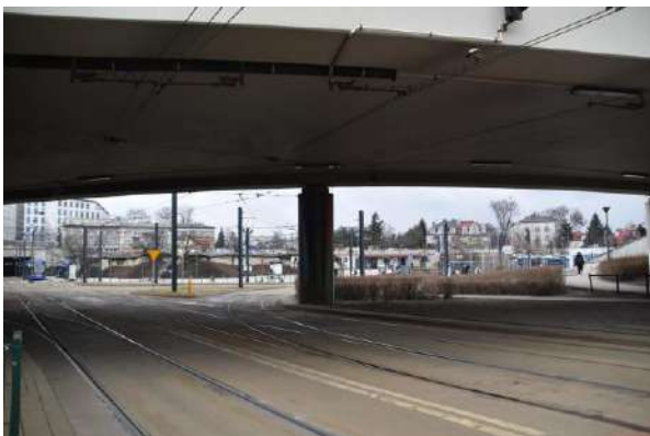
Fot. 26 Torowisko pod Rondem Mogiłskim – miejsce znajdujące się częściowo w zasięgu przedsięwzięcia (źródło: Ekovert)
