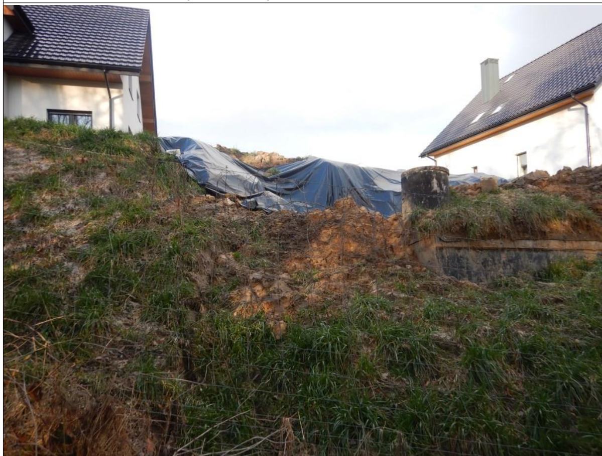
Widok na skarpe główną osuwiska (na pierwszym planie widoczny betonowy zbiornik na wody)
