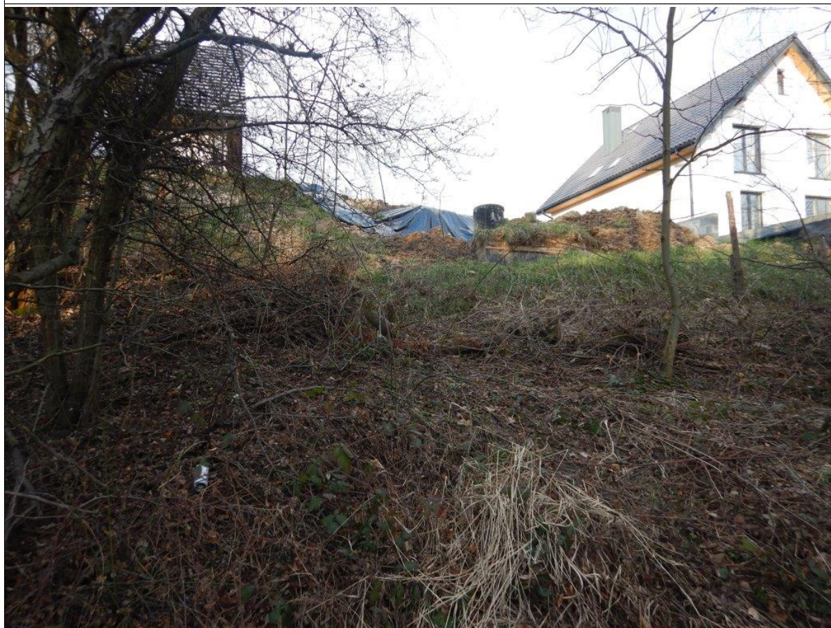
Widok na osuwisko od strony zachodniej
