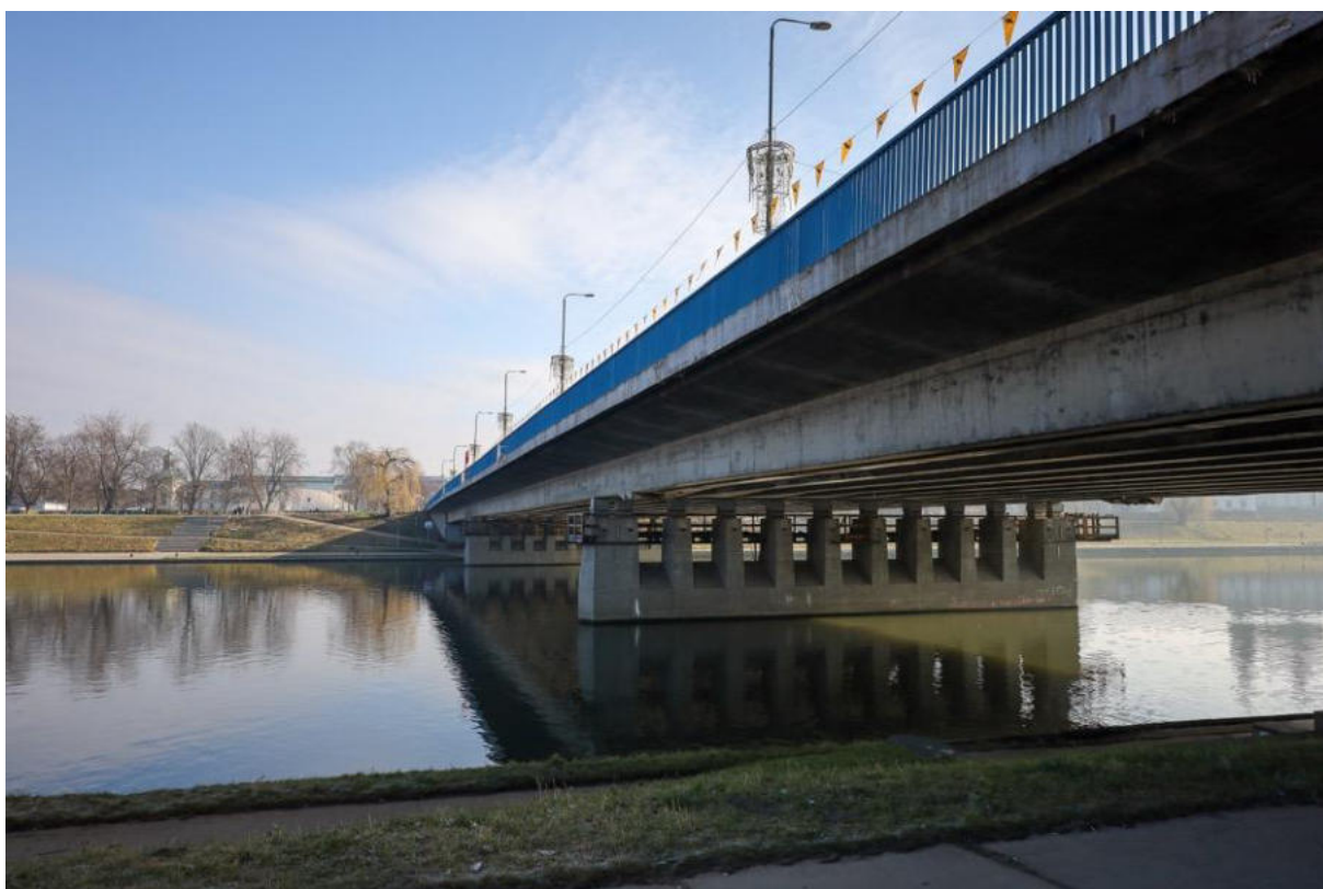
Fot. 22. Widok na most od strony zachodniej.
