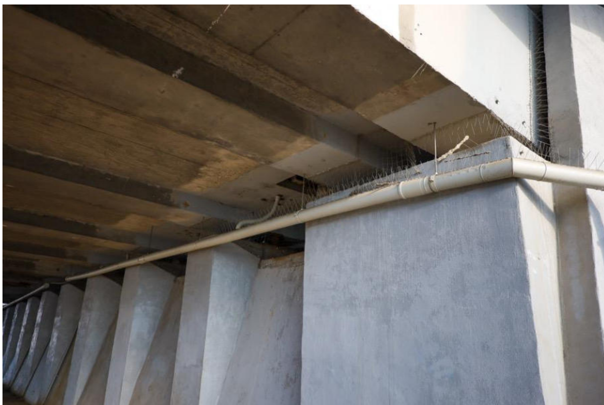
Fot. 6. Liczne zabezpieczenia przed gniazdowaniem i przesiadywaniem gołębi stwierdzono na filarach mostu.
