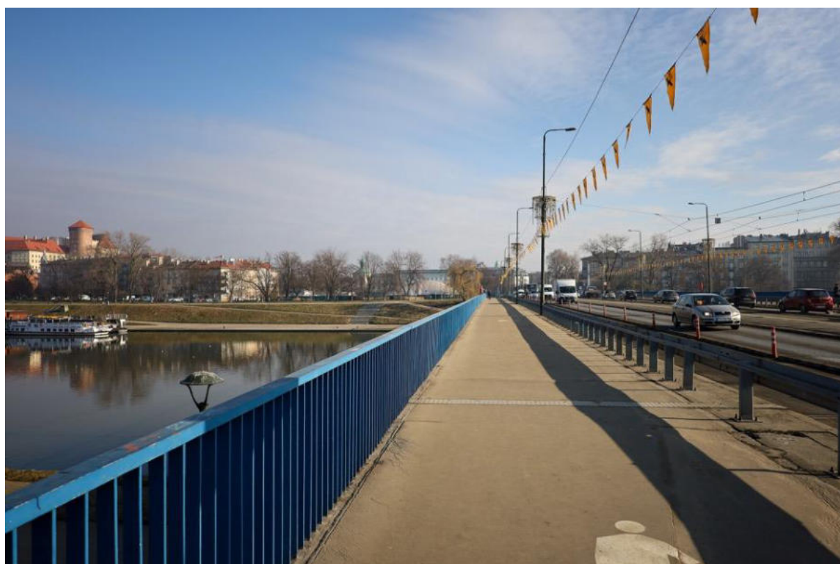
Fot. 30. Widok na chodnik w obrębie mostu.
