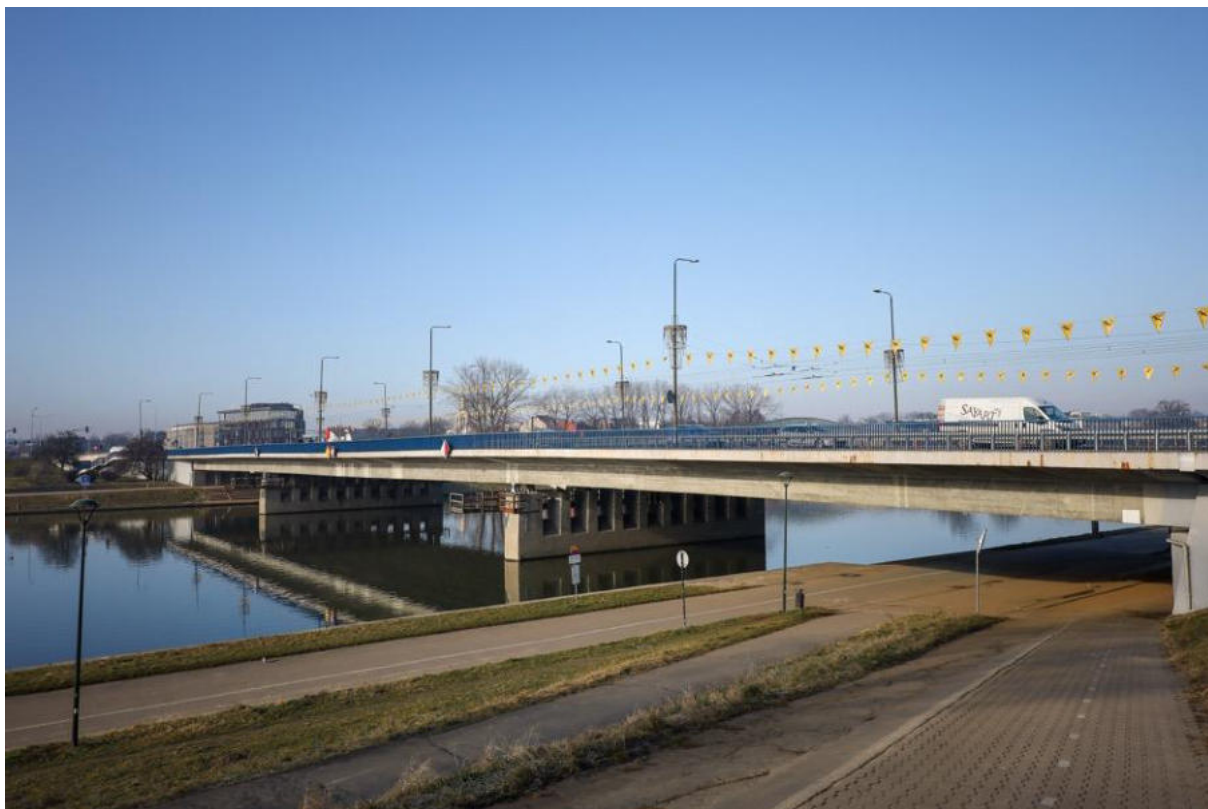
Fot. 3. Widok na most i najbliższe otoczenie.
