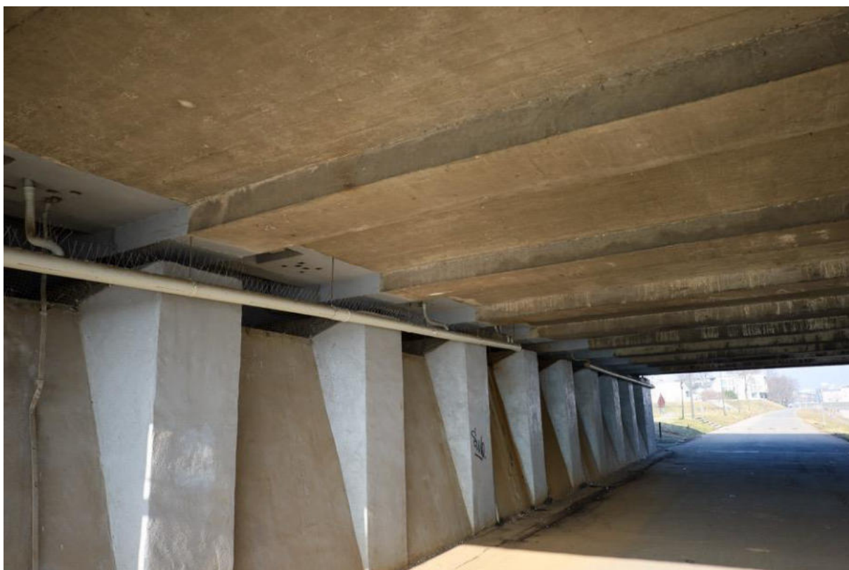
Fot. 20. Obie strony mostu zabezpieczone przy filarach na przyczółkach przed przesiadywaniem i gniazdowaniem gołębi.
