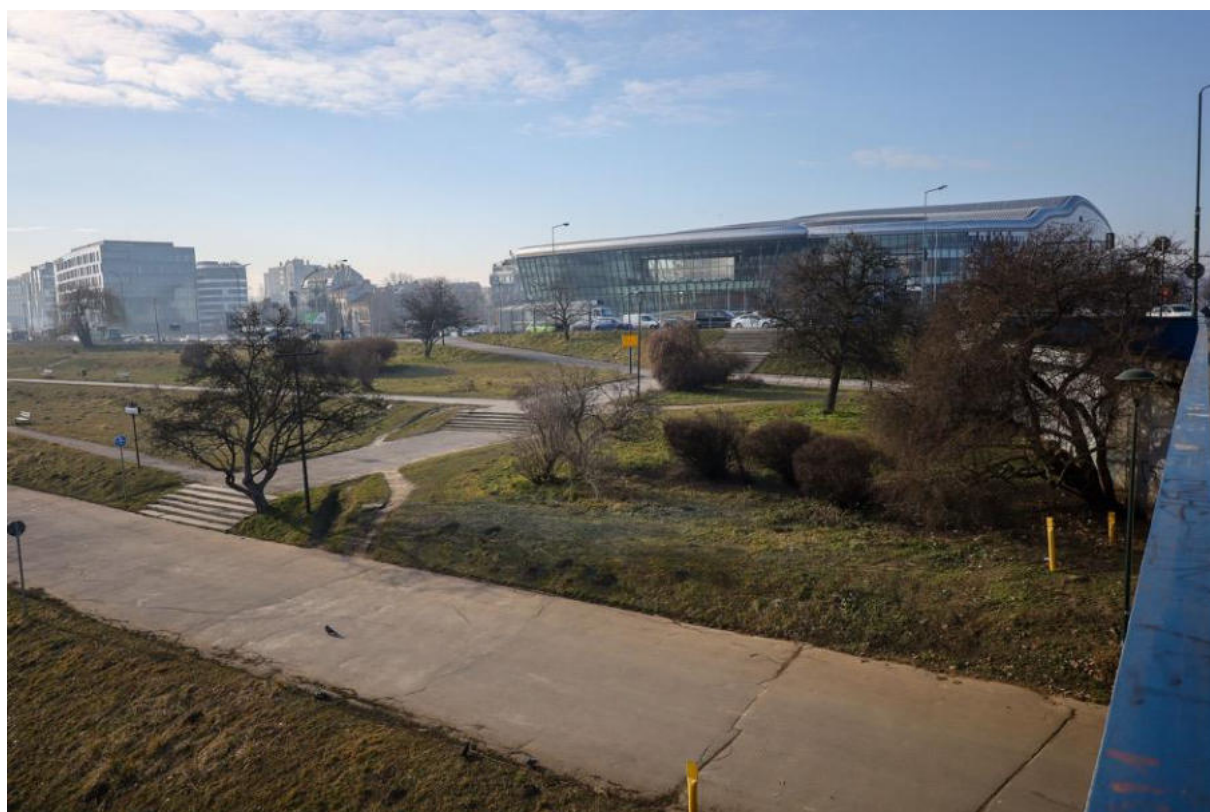
Fot. 16. Otoczenie mostu – zielenć urządzona, gatunki ozdobne.
