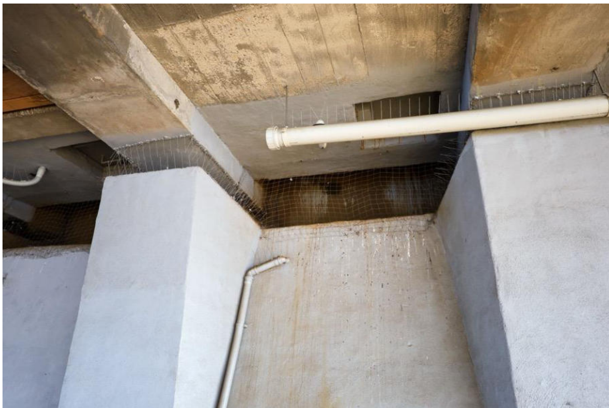
Fot. 7. Siatki zabezpieczające przed gołębiami oraz ślady odchodów gołębi.
