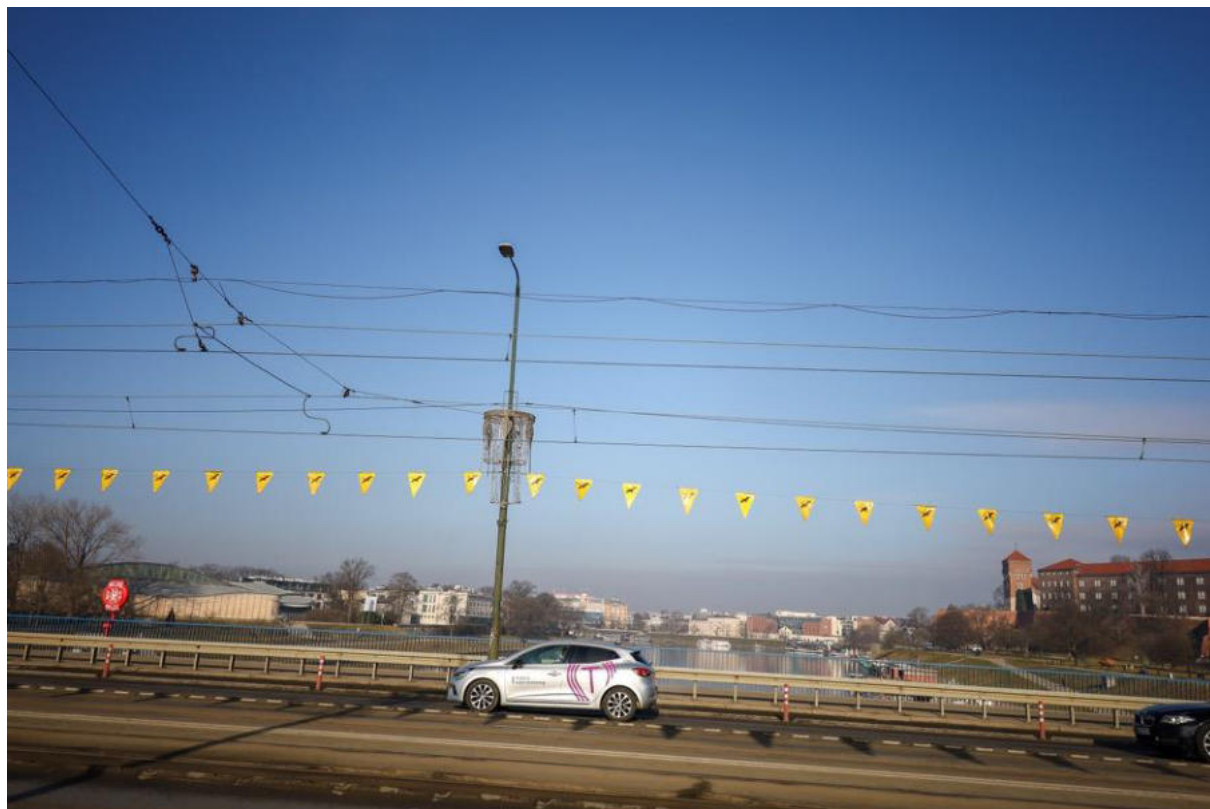
Fot. 15. Rozwieszone proporce w celu wyeliminowania kolizji ptaków z linią trakcyjną tramwajów.
