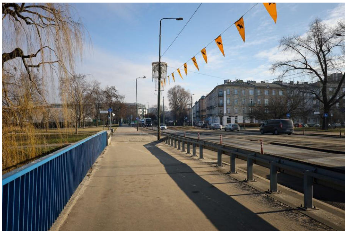
Fot. 31. Widok na chodnik w obrębie mostu.
