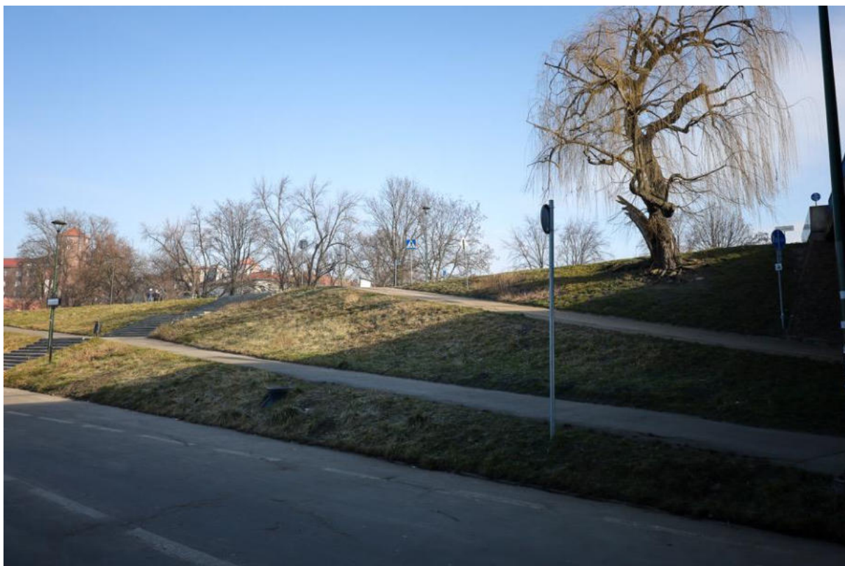
Fot. 12. Otoczenie mostu bardzo ubogie pod względem przyrodniczym – nisko koszone trawniki i pojedyncze drzewa (na zdjęciu najbliżej mostu – wierzba).
