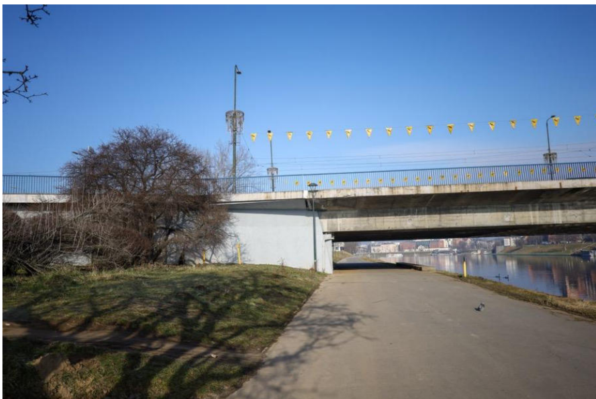
Fot. 18. Gołębie na alejkach spacerowych.
