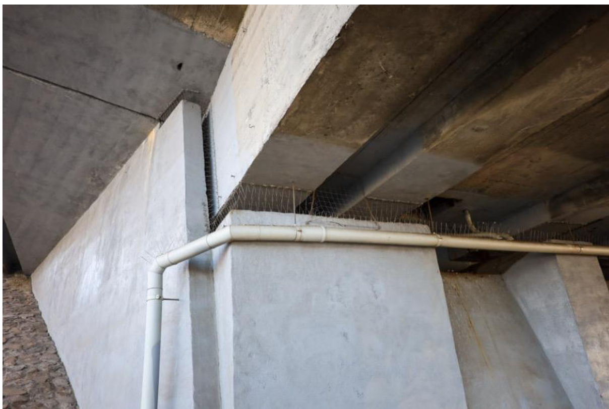
Fot. 8. Zabezpieczenia przed gołębiami pokrywały praktyczne całe filary wzdłuż ciągów pieszych.
