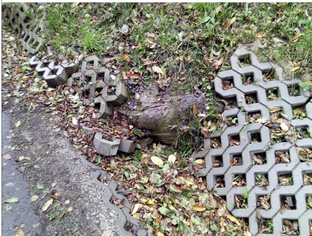
Fot. 4. Słaboprzepuszczalny materiał zastosowany jako podkład pod płyty ażurowe
