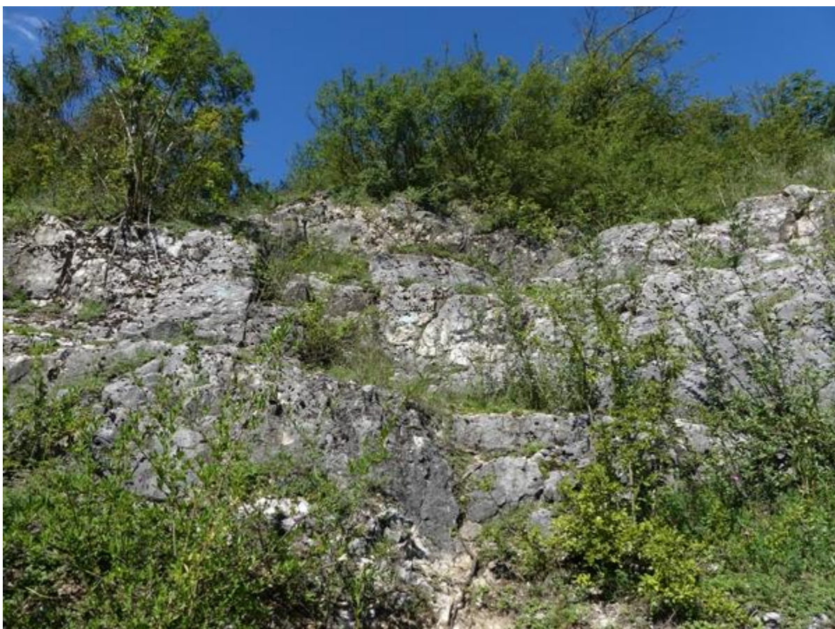
Zdjęcie 160 Dostępne a niezabezpieczone ściany wapienne mogą grozić upadkiem
